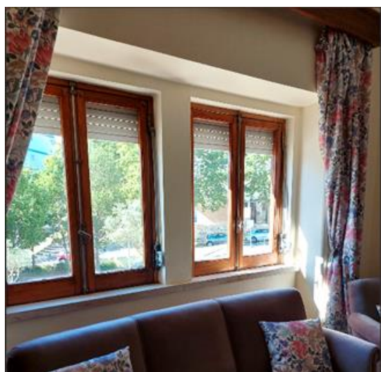
Figura 4.6 – Aspeto dos vãos de madeira (Fonte: Jorge Mascarenhas), junho 2022.
