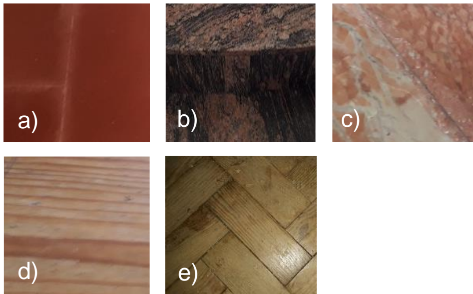
Figura A5.5 – Estereotomia dos pavimentos interiores: a) tijoleira cerâmica; b) mármore rosa e verde; c) pedra lioz; d) madeira pinheiro bravo; e) parquet (Fonte: de autor).
