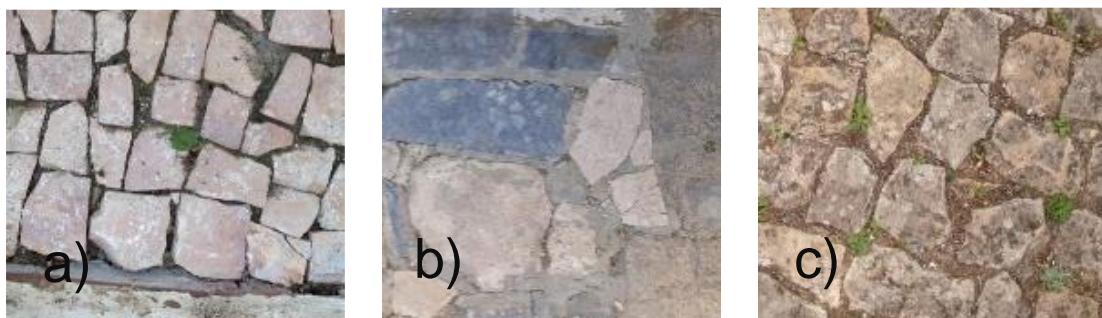
Figura A5.6 – Estereotomia de pavimentos exteriores: a) cubos de pedras em formato irregular, cor rosa; b) fragmento de pedra em formato irregular, cor cinza escuro e bege; c) cubos de pedra em formato irregular, cor cinza claro (Fonte: de autor).
