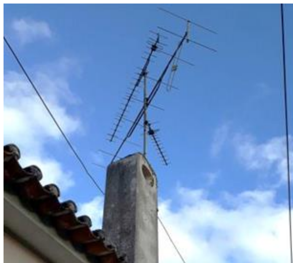
Figura 4.10 – Antenas fixas no topo da chaminé (Fonte: de autor), junho 2022.
